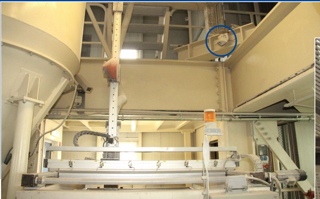
MOBOTIX-Kameras setzen sich in aufwändigem Test vor Ort gegen Bestandssystem durch
